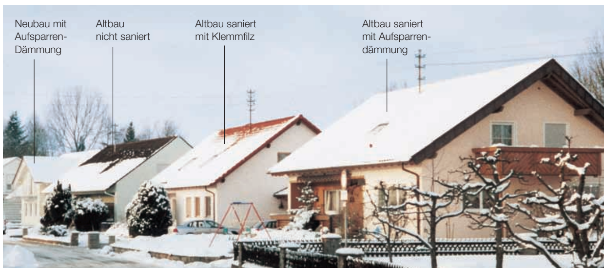
Die „Schneesmelze“ auf diesem Foto macht es deutlich: Eine unzureichende Dämmung führt im Winter zu hohen Wärmeverlusten. Ganz links ein Neubau mit Aufsparrendämmung Kingspan Therma™ TP11 Dämmstoffplatten. Es folgen ein Altbau ohne Dämmung sowie ein mit Klemmfilz sanierter Altbau. Ganz rechts ist ein Altbau zu sehen, der mit Kingspan Therma™ TP12 Dämmstoffplatten auf den Sparren saniert wurde. Der sichtbare Effekt: Je wirkungsvoller die Dämmung und je weniger Wärme übers Dach entweicht, desto mehr Schnee bleibt liegen.
